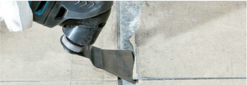
Odsekávání dlaždic B-21456
